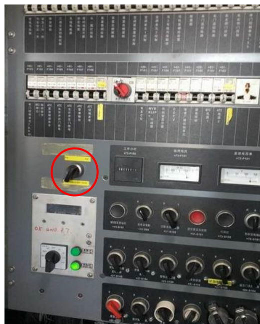
图 4.31 模式转换开关位置
