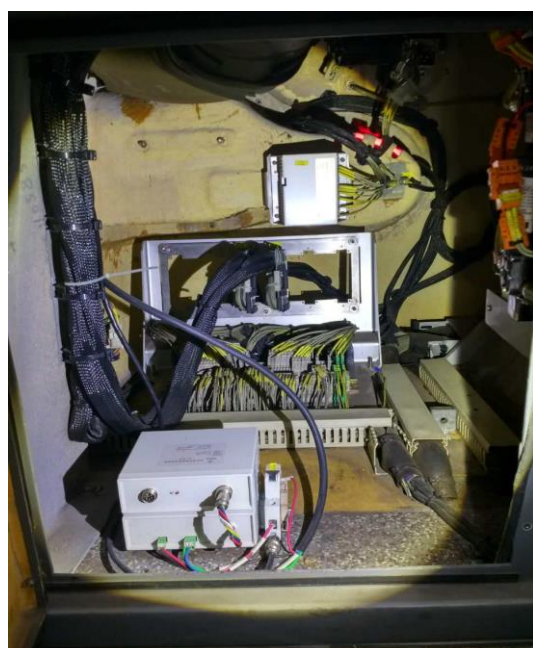
图 4.30 光敏节能控制器位置
